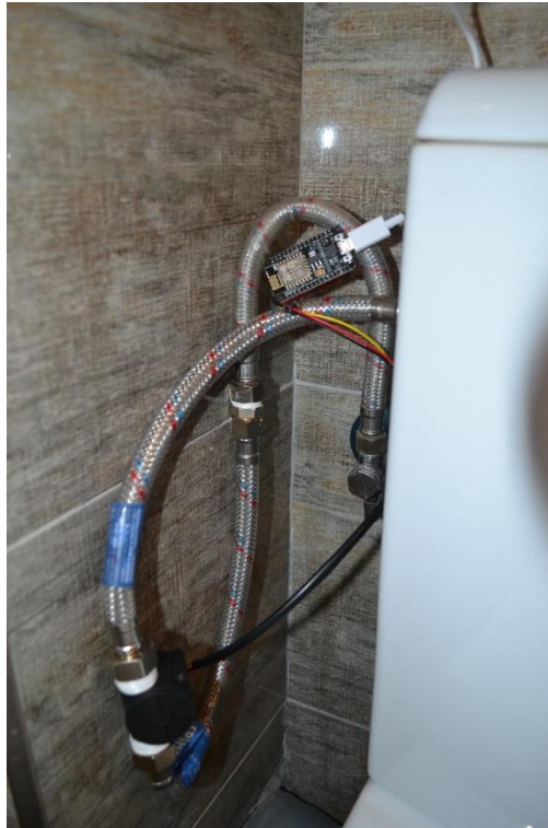
Fig. 20 Montaj debitmetru conectat la NodeMCU alimentat cu sursa AC / DC
